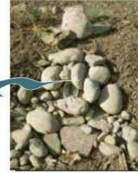
Kameňmi vydlážděný vstup. Kamene by mali byť bez usadenín (dôkladne umyté)
