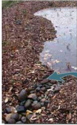
Kameňmi vydlážděný odtok
